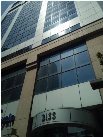
The ER building
